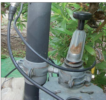
Bild 4: Mastbefestigung an der Deichsel mit zwei zusammengeschraubten Rohrschellen
